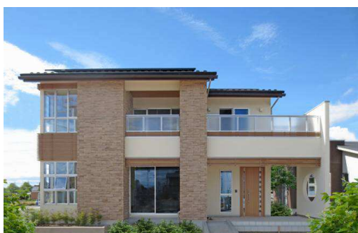
<フィアスホーム「アリエッタ」外観写真>
