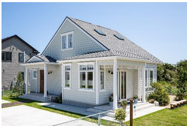
GLホーム神栖店モデルハウス外観
